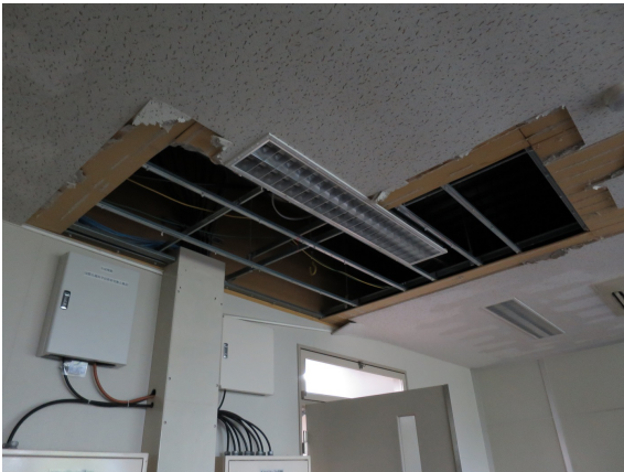
図 1.1: (左) 天井材が落ちた天井, (右) 水濡れした L3 スイッチ
